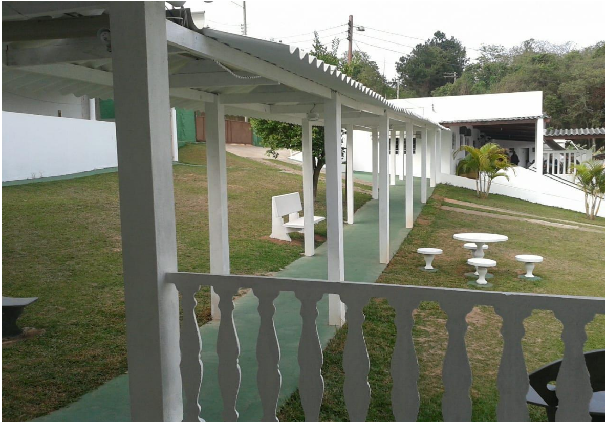
Figura 5 – Corredor com cobertura situado entre as duas alas.
